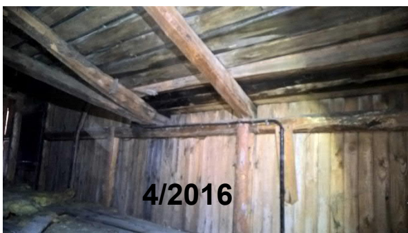
Kuva 7. Katon vuotokohdat olivat syksyllä 2019 kuivempia aiemmista vesisateista huolimatta, kuin keväällä 2016, joten vuodot liittyvät pääosin lumien sulamiseen ja sen muodostamiin jääpatoihin.
