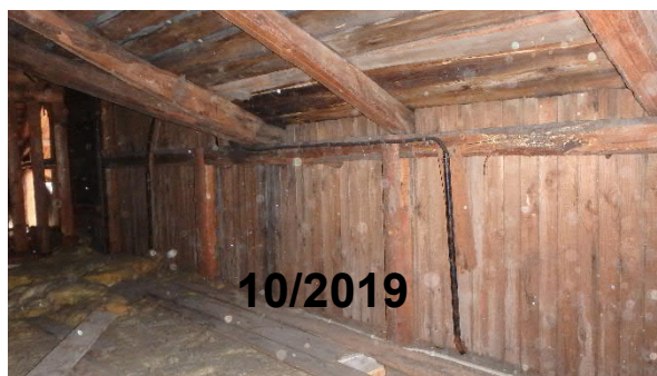
Kuva 7. Katon vuotokohdat olivat syksyllä 2019 kuivempia aiemmista vesisateista huolimatta, kuin keväällä 2016, joten vuodot liittyvät pääosin lumien sulamiseen ja sen muodostamiin jääpatoihin.
